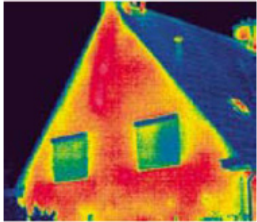
Fotografiile termografice indica pierderile de energie. Zonele rosii sunt cele mai slab izolate.
